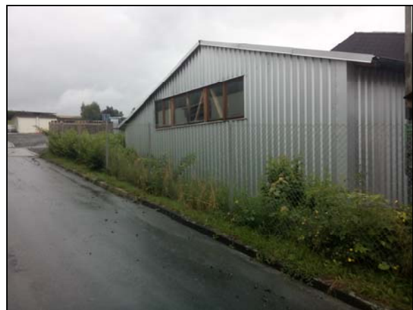
Abb. 4: Ziergehölzstreifen im Südwesten
